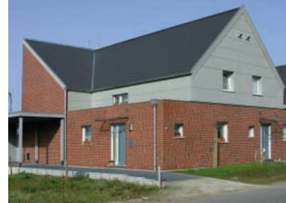
Häusergruppe aus 6 Doppelhaushälften im Passivhausstandard, Wassenberg. Die Häuser sehen mit Satteldach und Verklammerung aus wie ganz normale Wohnhäuser.
