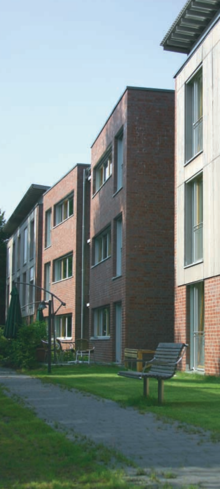
Blick entlang des dreigeschossigen Hauptbaukörpers
