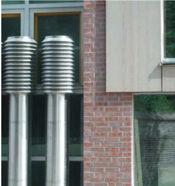
Fassadenausschnitt: Zusammenspiel aus Edelstahl-Ansaugstutzen der Lüftungsanlage, Lärche-Holztafeln, Klinker und Fensterelementen.
