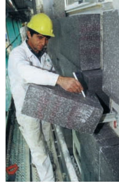
Anbringen des Dämmstoffs
