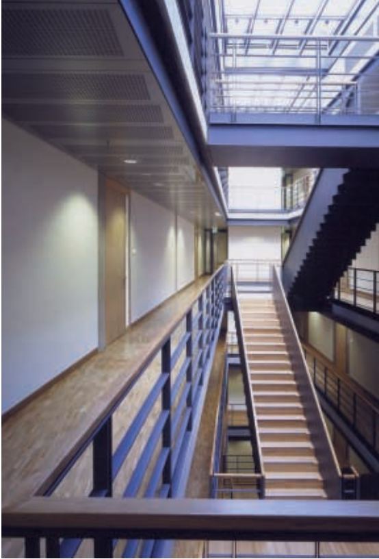
„Stadtfrage“ im Jakob-Kaiser-Haus: Dachflächenfenster für Tageslicht in den Treppenhäusern bis ins Untergeschoss
