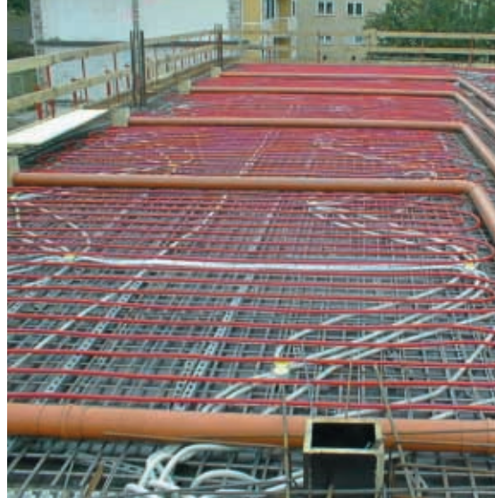
Das Verlegen der PCM-Kühldecke
