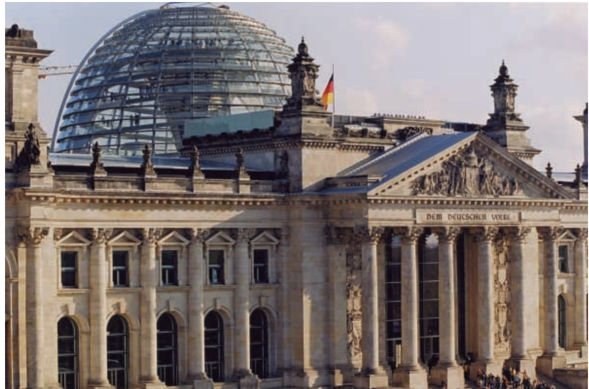
Das von Sir Norman Foster zum Plenarbereich des Deutschen Bundestages umgebaute Reichstagsgebäude
