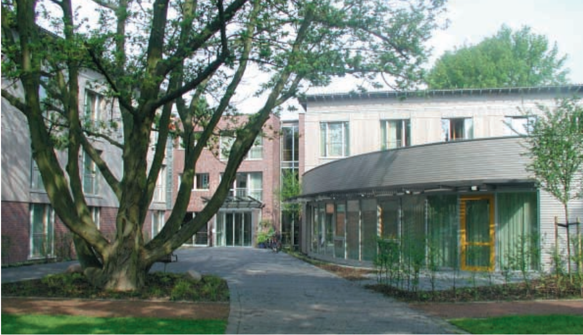
Blick entlang des dreigeschossigen Hauptbaukörpers
