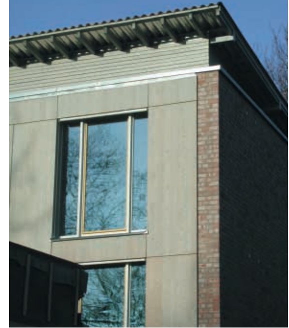
Giebelndetail: Holzverschalung, Klinkerfassade und Dach mit Aluminiumverkleidung
