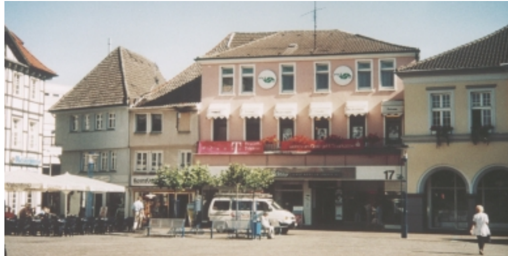
Gebäude vor dem Abriss
