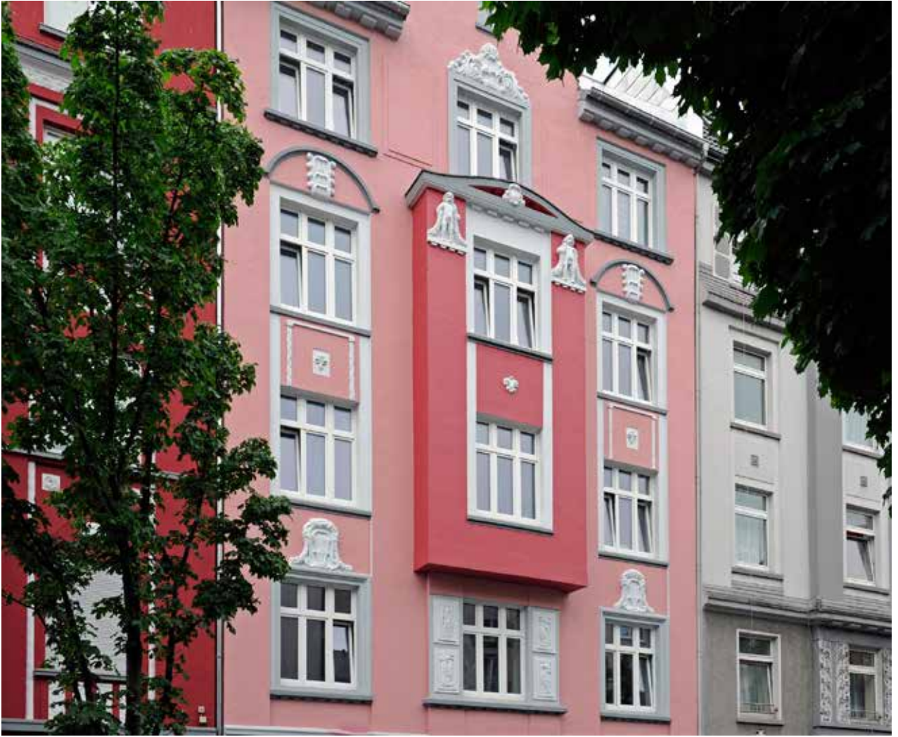
Abb. 8: Dortmund, Brunnenstraße 51, nach der Sanierung
