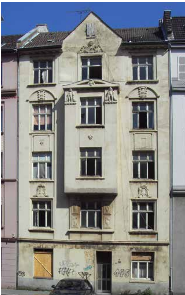
Abb. 7: Dortmund, Brunnenstraße 51, vor der Sanierung
