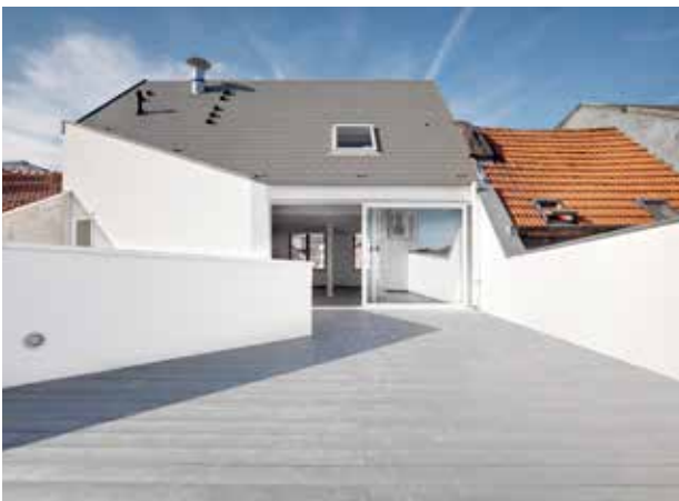
Abb. 9: Antwerpen, Falconplein. Das von dem jungen Architekturbüro PULS entworfene Wohnhaus ersetzt eine Schrottimmoblie.
