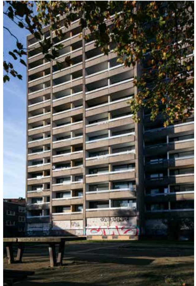
Abb. 5: Dortmund, Kielstraße 26. Das Punkthochhaus mit 102 Wohneinheiten wurde bereits 2002 im Rahmen einer bauordnungsbehördlichen Sicherungsmaßnahme zugemauert und soll abgerissen werden.
