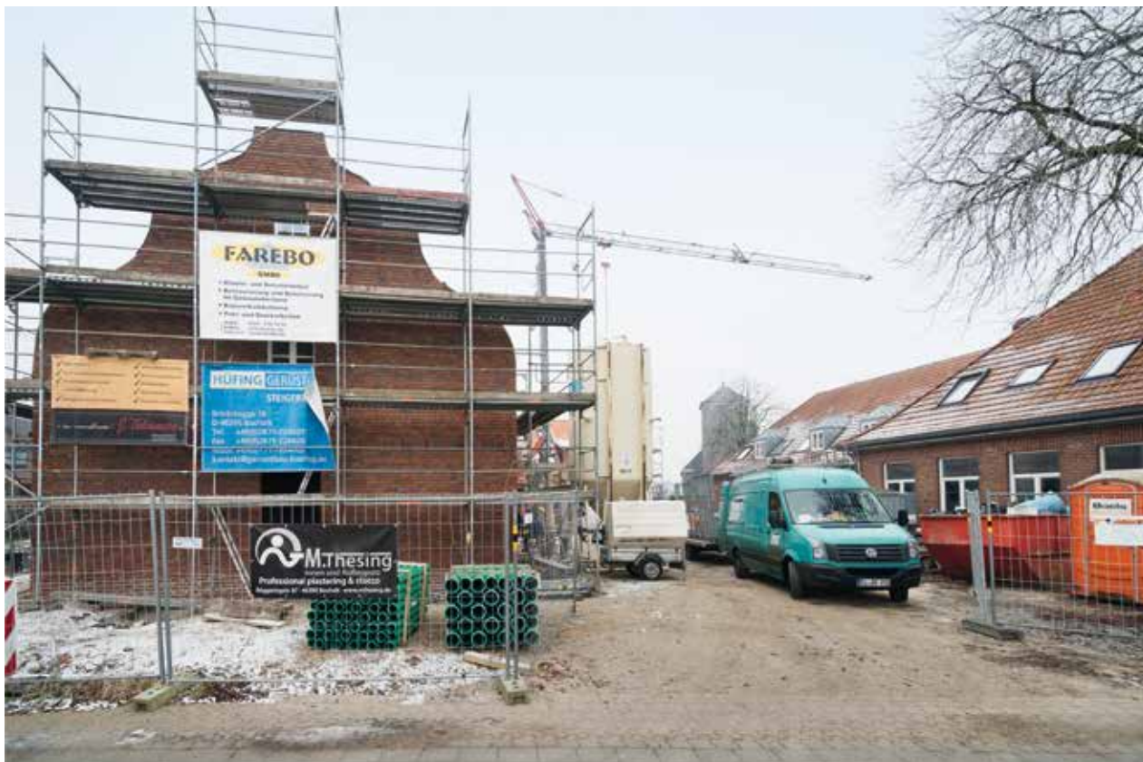
Abb. 3.18: Neubau des Ludgerushofs auf dem ehemaligen Schulhof
