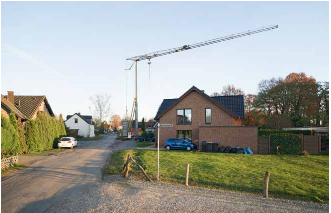
Abb. 3.12: Hier wird gebaut: Voerde-Spellen.
