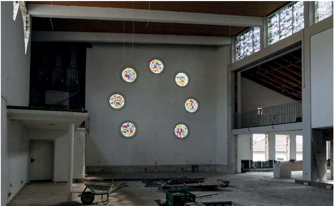
ehemalige Paul-Gerhard-Kirche während des Umbaus
