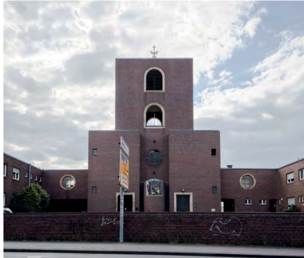
ehemalige Kirche von Osten nach der Umnutzung
