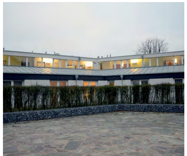
Kirche und Platz nach der Sanierung, Neubau Seniorenwohnungen
