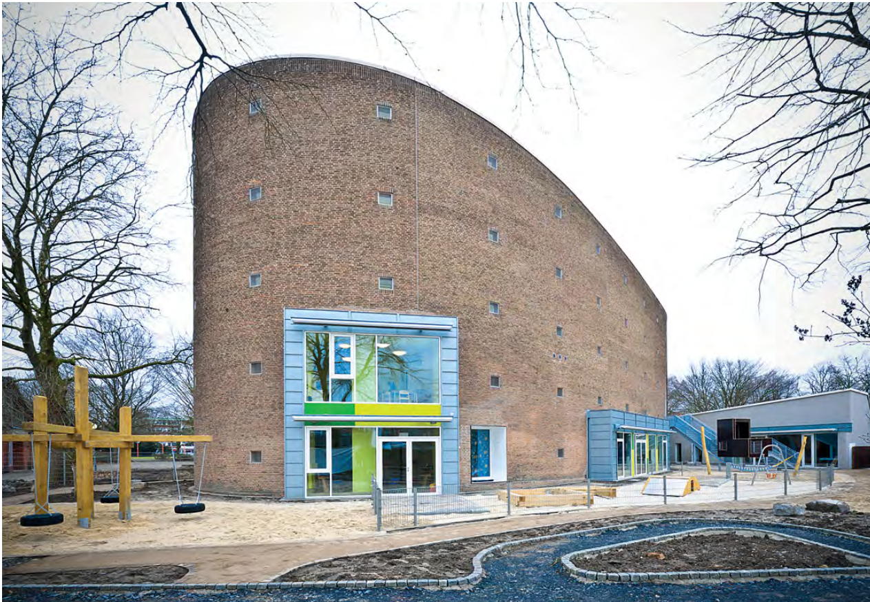
Kirchengebäude mit rückwärtigem Zugang zur Kindertagesstätte
