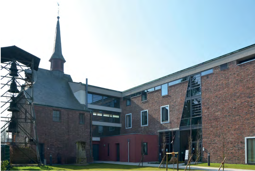
Neuer Haupteingang in der Ostfassade nach dem Umbau
