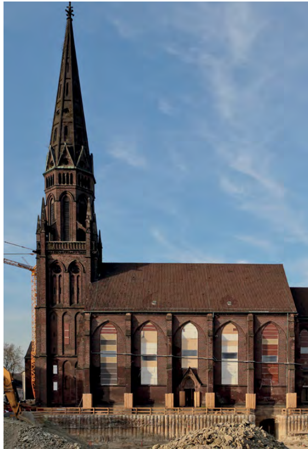
ehemalige St. Marienkirche von Süden während des Umbaus
