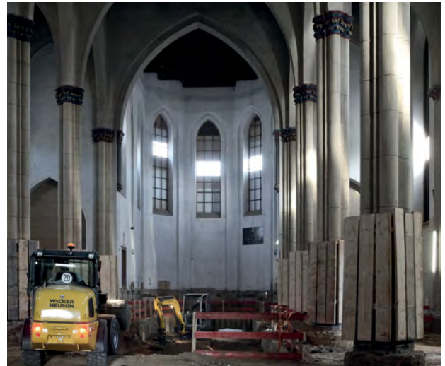
ehemalige Marienkirche während des Umbaus
