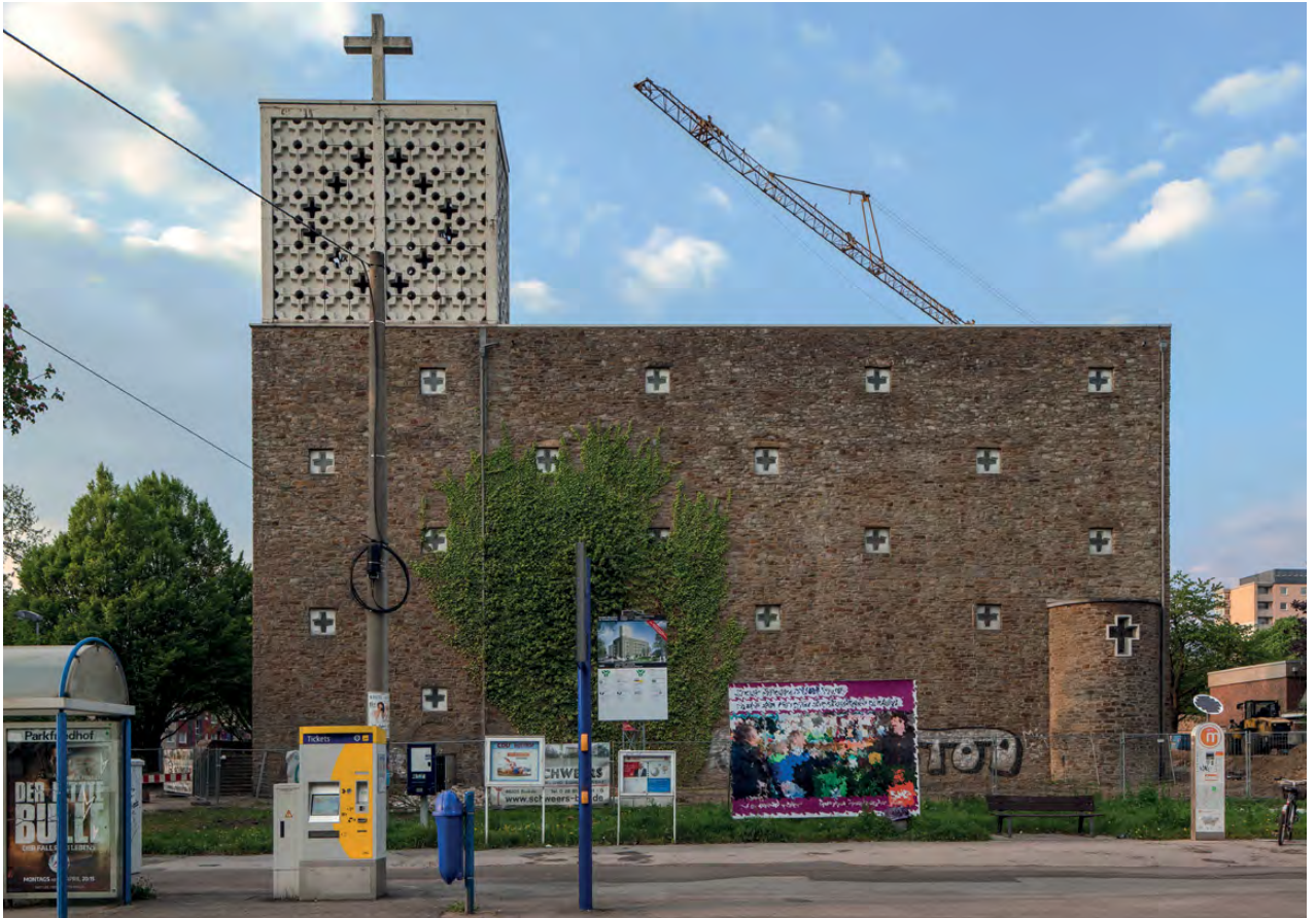
Südfassade während des Umbaus
