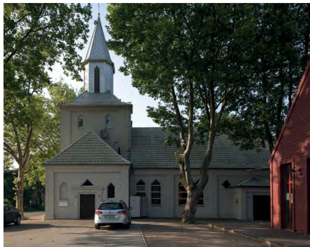
Kirchengebäude vor und nach der Sanierung
