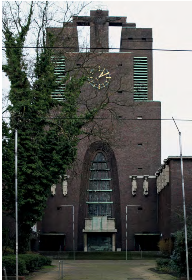
Vorplatz und Eingangsfassade vor der Umnutzung
