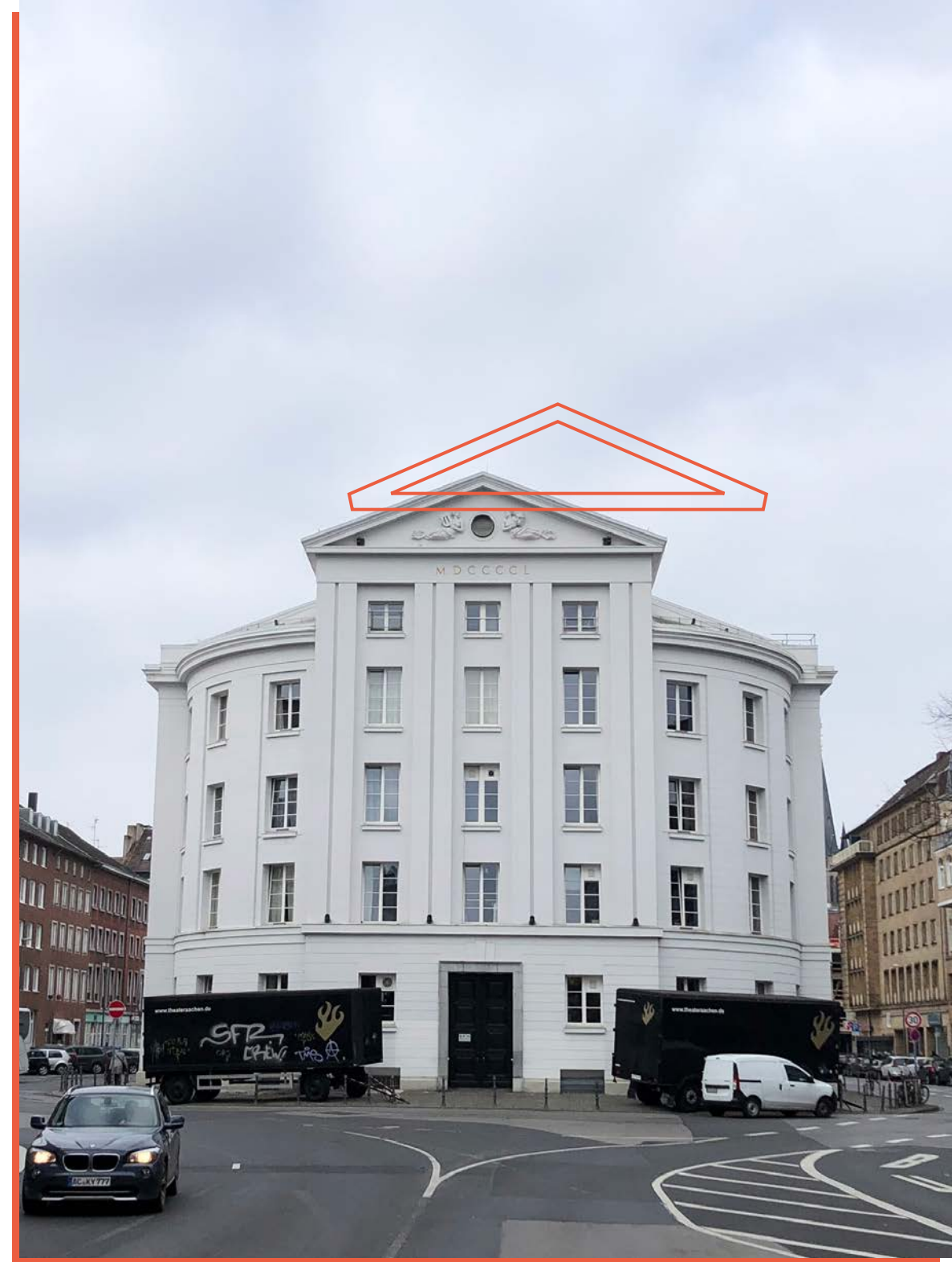
Die Rückseite des Aachener Theaterbaus.
