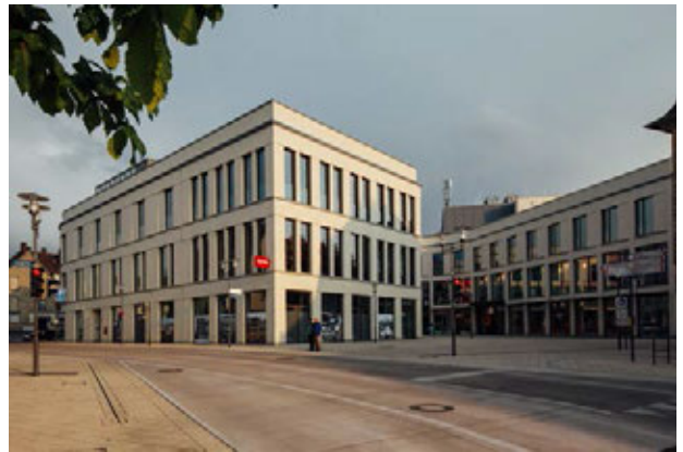
Abb. 26: Detmold, umgebautes Warenhaus
