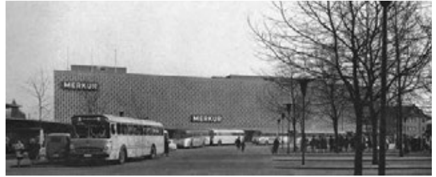
Abb. 12: Neuss, ehemaliges Merkur-Warenhaus, später Horten, um 1963
