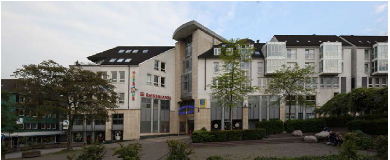
Abb. 41: Wuppertal, Rathaus-Galerie, Eingang am Karlsplatz
