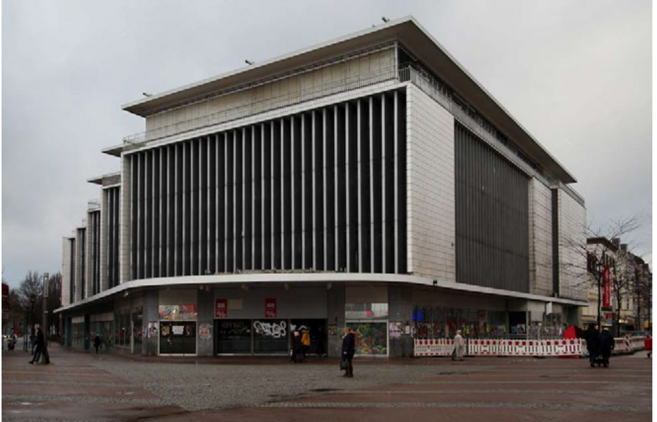
Abb. 7: Herne, ehemaliges Warenhaus Hertie, seit 2009 leerstehend
