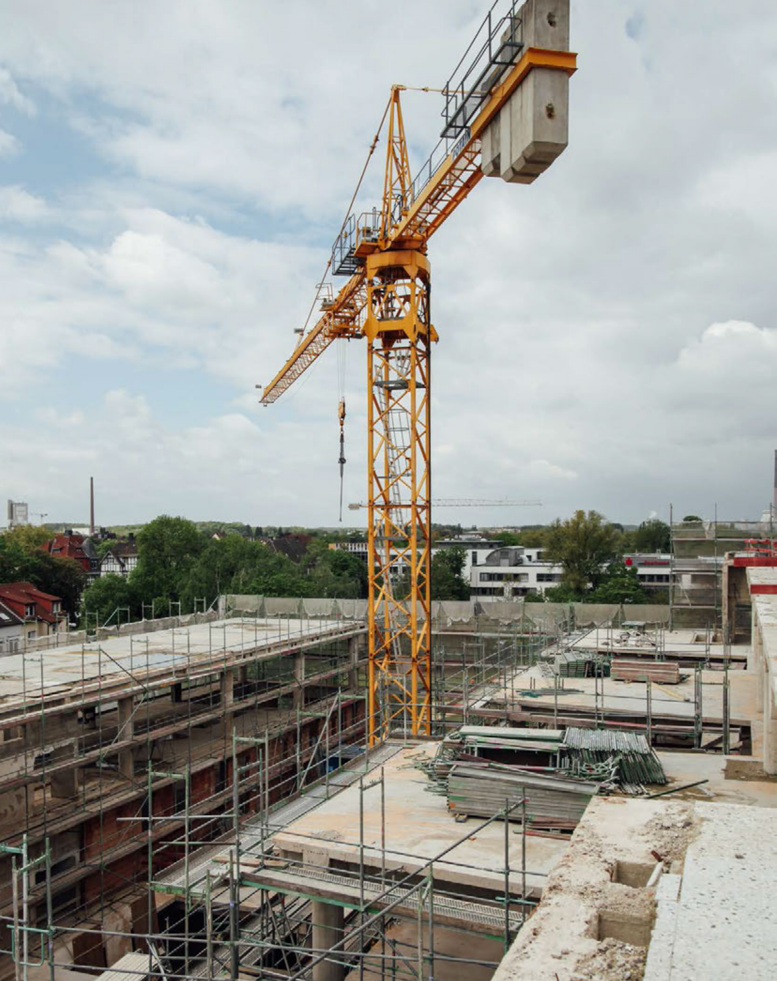
Abb. 8: Lünen, ehemaliges Warenhaus Hertie während des Umbaus
