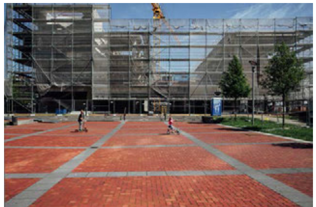
Abb. 19: Lünen, ehemaliges Hertie-Warenhaus, vor und während des Umbaus
