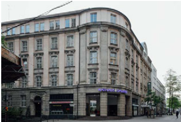
Abb. 42: Wuppertal, Rathaus-Galerie, Eingang an der Friedrichstraße
