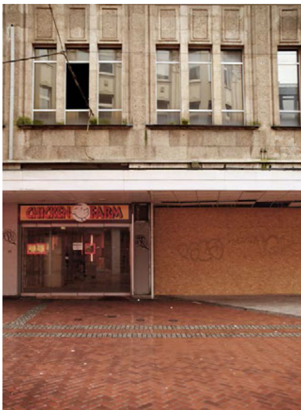
Abb. 22: Gelsenkirchen, ehemaliges Hertie-Gebäude, vor dem Umbau
